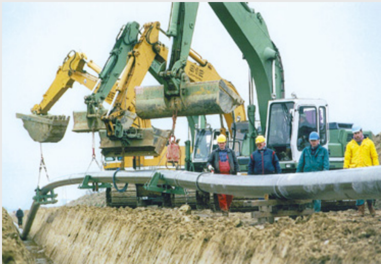
Bild 3: Biegeradien bei der Verlegung verschweißter Rohrstränge
