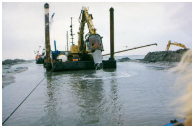
Abb. 7 und 8: Seeverlegung einer zementmörtelummantelten Abwasserdruckleitung zwischen Esbjerg und der Insel Fanø, Dänemark
