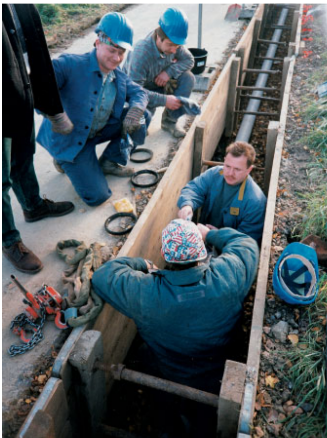
Abb. 11: Typische Verbaumaßnahme bei der Verlegung von Steckmuffenrohren
