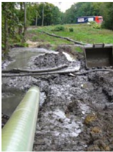
Bild 2: Einzug eines Stahlrohrs im Spülbohrverfahren
