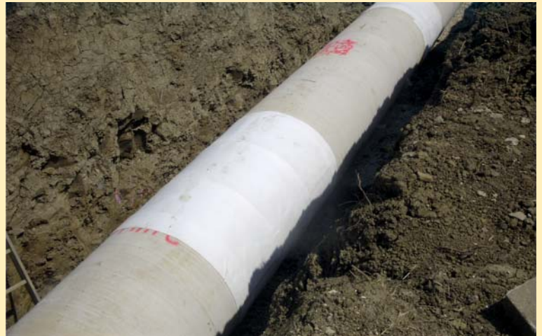
Bild 17. Rohrschutzmatte als zusätzlicher mechanischer Schutz im Schweißnahtbereich.
