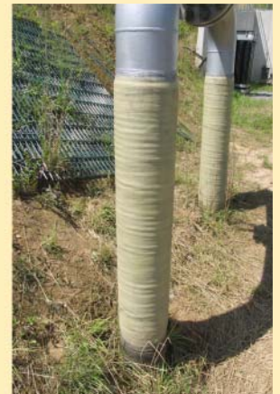
Bild 18. Umhüllung eines Boden-Luft-Übergangs mit Butylkautschukband-GfK-System.
