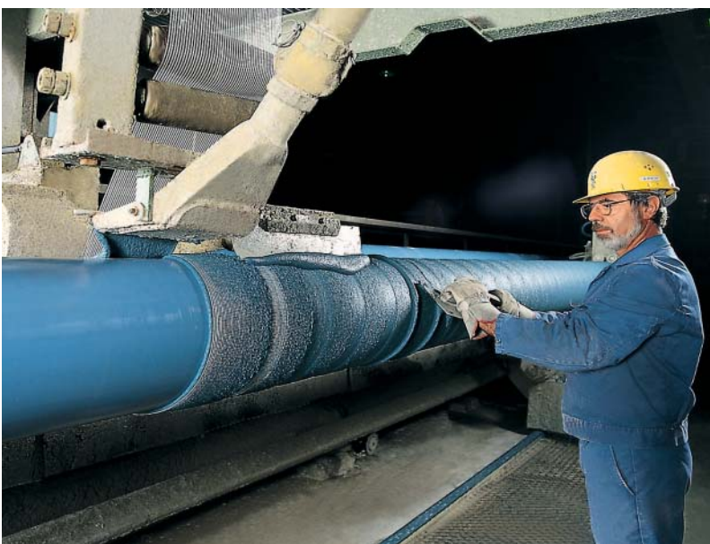
Bild 9. Herstellung einer FZM-Ummantelung.
