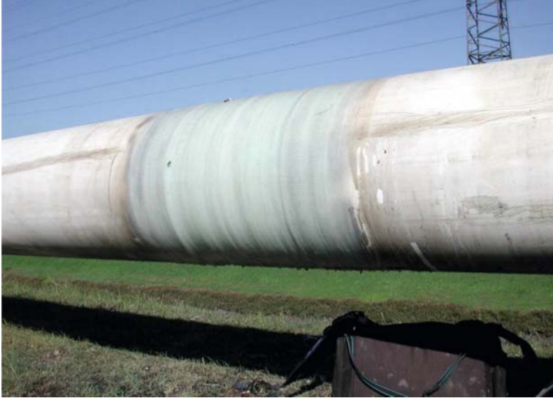
Bild 15. GfK-Schweißnahtumhüllung für grabenlose Verlegung.
