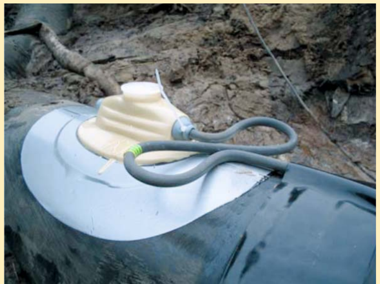
Bild 19. Nachumhüllung eines Kabelanschlusses mittels Kabelvergusset.
