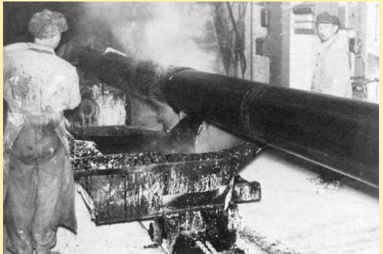
Bild 1. Rohrbeschichtung mit geschmolzenem Teer (um 1935).
