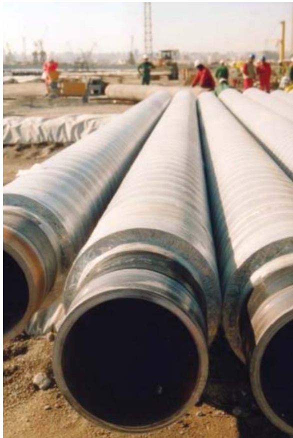
Bild 7. PP-Umhüllung mit Rough Coat und Heavy Weight FZM Ummantelung.
