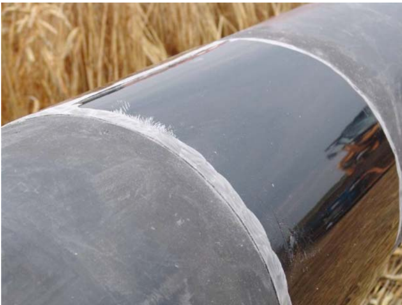
Bild 16. PUR-Schweißnahtumhüllung für Spülbohrverlegung.
