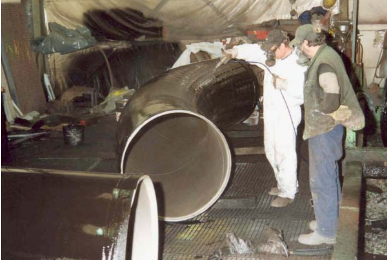
Bild 4. Spritzbeschichtung von Rohrbögen mit Polyurethan.
