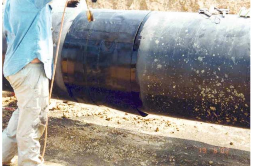
Bild 14. Aufbringen einer Dreischicht-Schrumpfmanschette.
