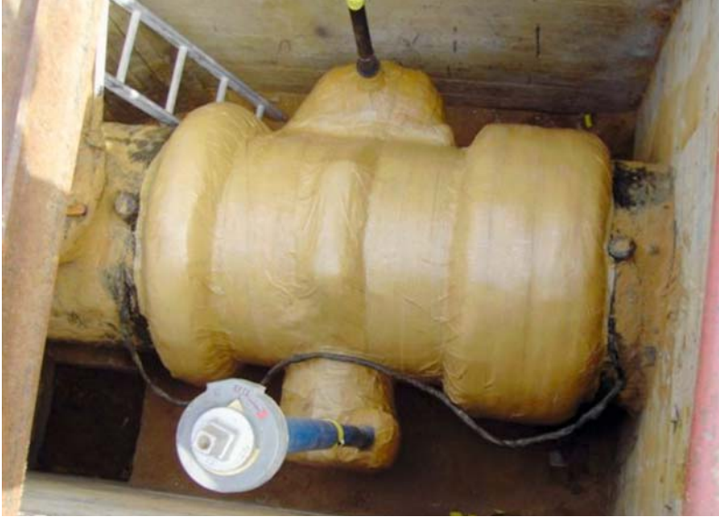
Bild 12. Nachumhüllung einer Armatur mit Petrolatumbändern.
