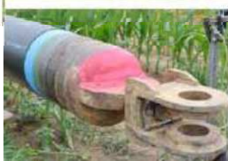
Bild 4: Verlegepflug und Zugeinheit
