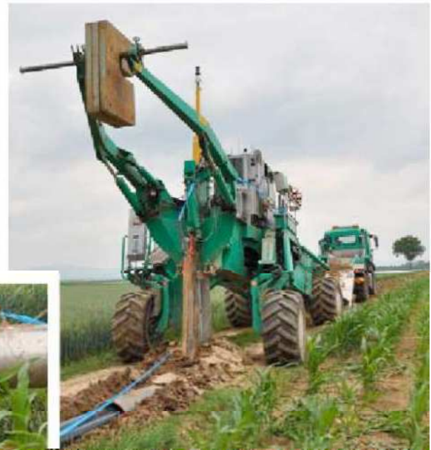
Bild 7: Pflügen des Rohrstranges
