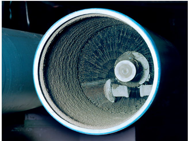
Abb. 2: Korrosionsschutz durch Zementmörtelauskleidung
