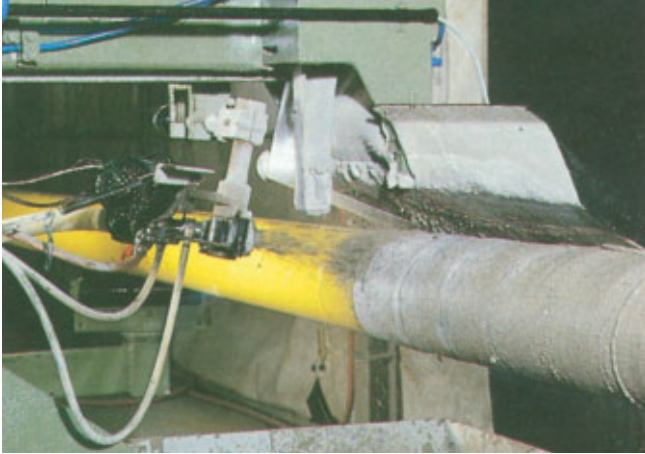
Abb. 2: Herstellung der Zementmörtelummantelung im Spritzverfahren
