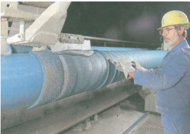
Abb. 3: Herstellung der Zementmörtelummantelung im Wickelverfahren
