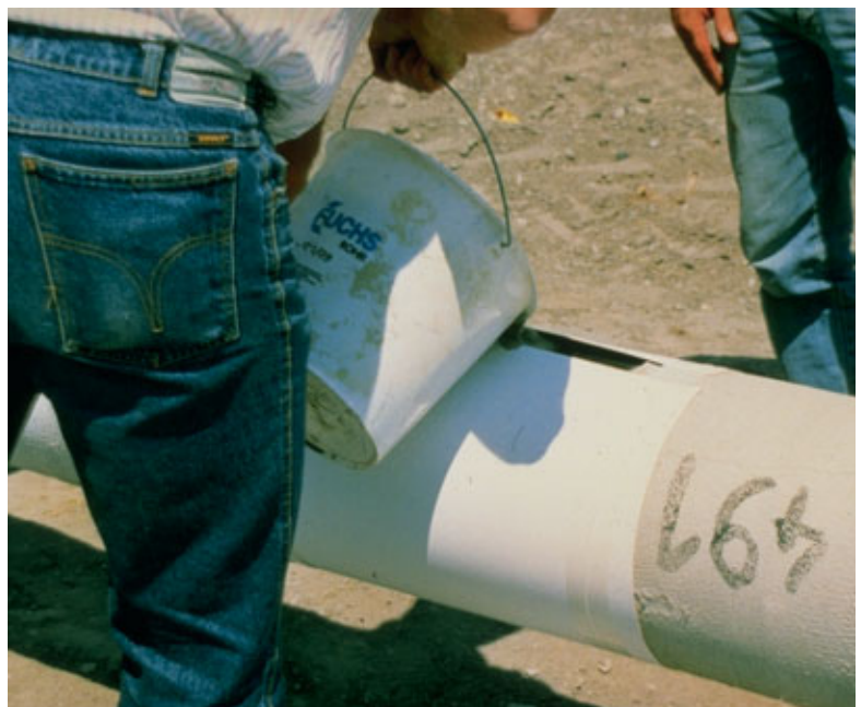
Abb. 6: Nachumhüllung der FZM-Ummantelung mit Gießmörtel
