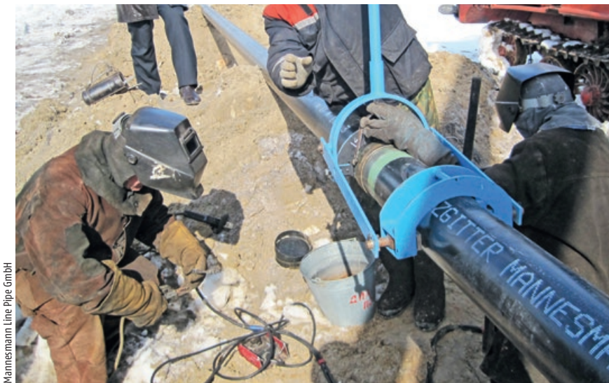
Abb. 7 – Verlegevorrichtung für die Wasserinjektionsleitungsrohre mit Innenzementauskleidung
