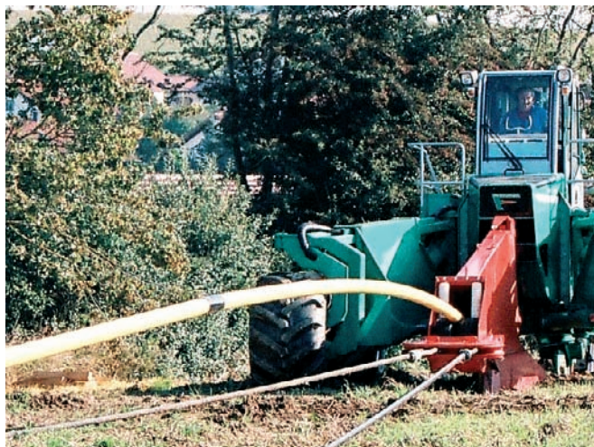
Bild 2: Strangführung mit Oberbogen
