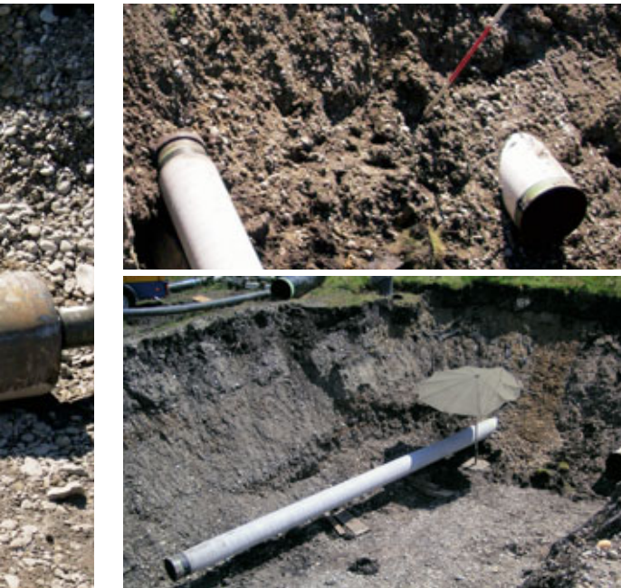
Abb. 6 und 7 Startgrube vor und nach der Versuchspressung
