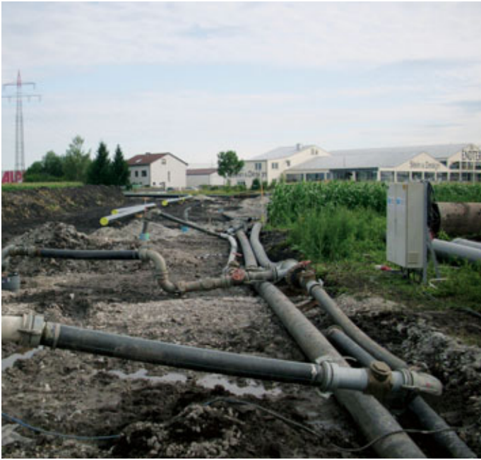
Abb. 4 Wasserhaltung im Trassenbereich
