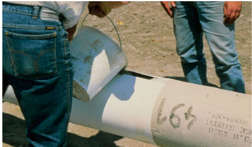
△ Abb. 2 Nachumhüllung der FZM-Ummantelung mit Gießmörtel
