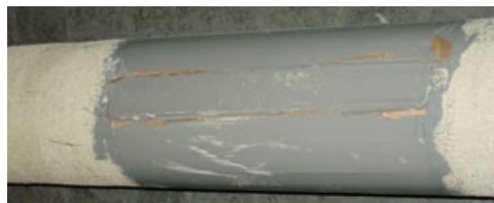
△ Abb. 2 Nachumhüllung der FZM-Ummantelung mit Gießmörtel
