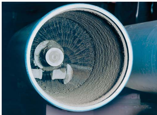
Bild 10. Schleuderkopf zum Auskleiden der Rohre.
