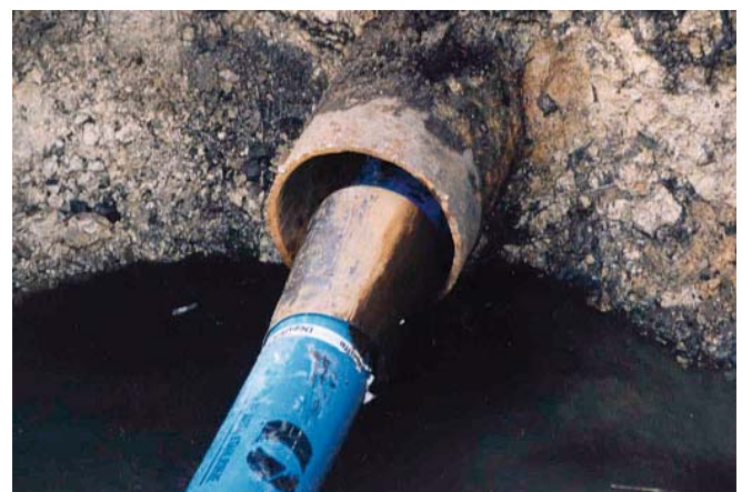
Bild 14. Verlegung eines Stahlsteckmuffenrohres mit dem Rohreinzugverfahren.
