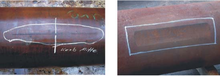
Bild 3: Eingebrachte Fehler: Rissartiger Defekt (links), volumenhafter Defekt (rechts)
