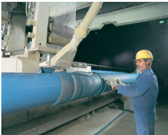
Abb. 2: Herstellung der Zementmörtelummantelung
