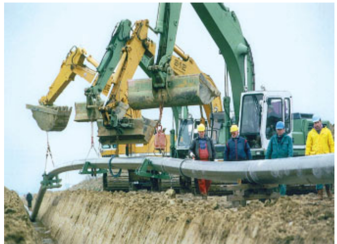
Abb. 4: Pipelineverlegung einer polyethylenumhüllten Stahlrohrleitung
