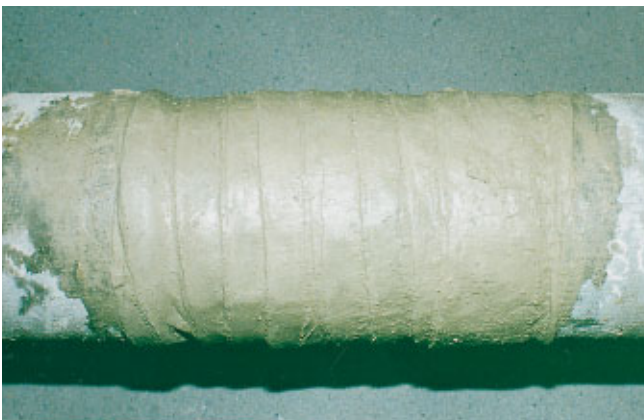
Abb. 4a und 4b: Gießmörtel und Zementbinde zur Vervollständigung der FZM-Umhüllung
