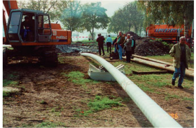
Abb. 12: Einzug des Rohrstranges
