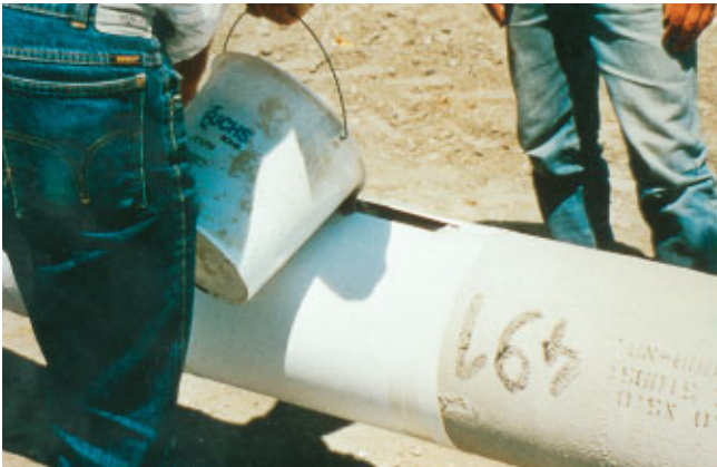
Abb. 5: FZM-ummüllte Gasleitung mit Feldbögen
