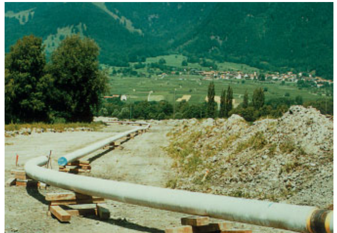
Abb. 5: FZM-ummüllte Gasleitung mit Feldbögen
