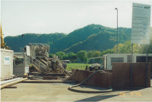
Abb. 11: Bohrergerät für die Zugkraft von 400 t
