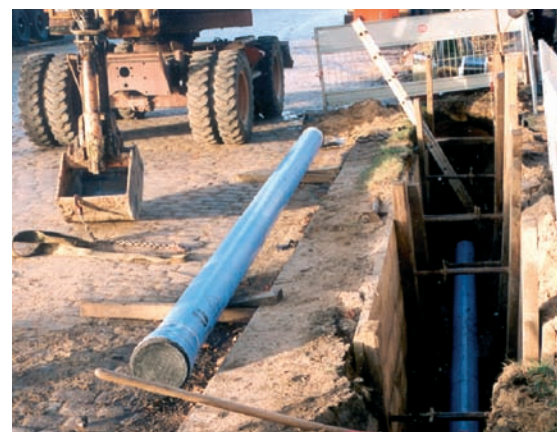
Bild 9: Hamburg, DN 200, Bauj. 2000 Fig. 9: Hamburg, DN 200, installed 2000
