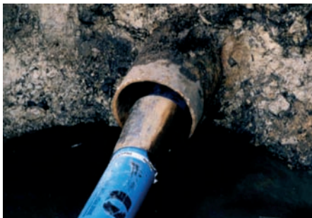
Bild 6: Einzug eines Stahlsteckmuffenrohres mit dem Rohrzugverfahren Fig. 6: Installation of a steel socket pipe using the pipe-pull method
