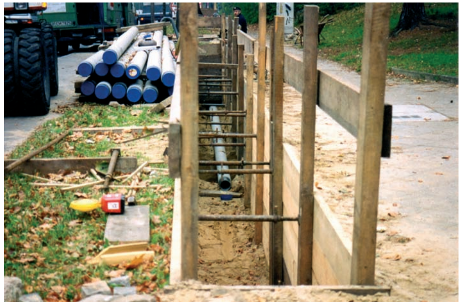
Bild 10: Montagegrube von Rohren für das Hydros-Verfahren
