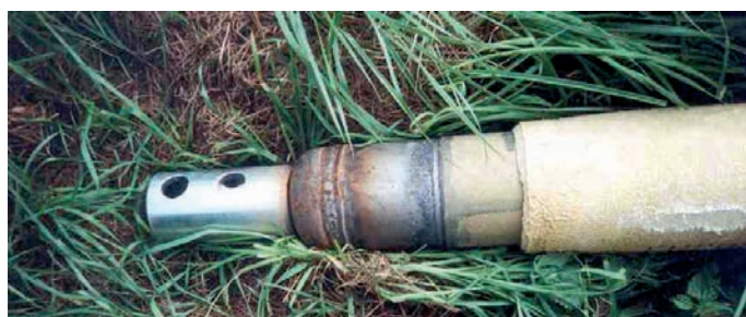
Bild 13: Stahlrohr mit Zugkopf Fig. 13: Steel pipe with jacking head
