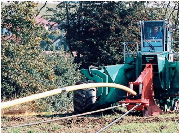
Bild 14: Strangführung mit Oberbogen
