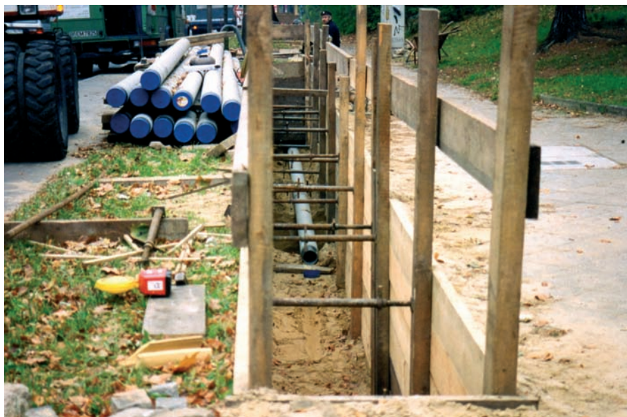
Bild 10: Montagegrube von Rohren für das Hydros-Verfahren Fig. 10: Pipe installation pit for the Hydros method
