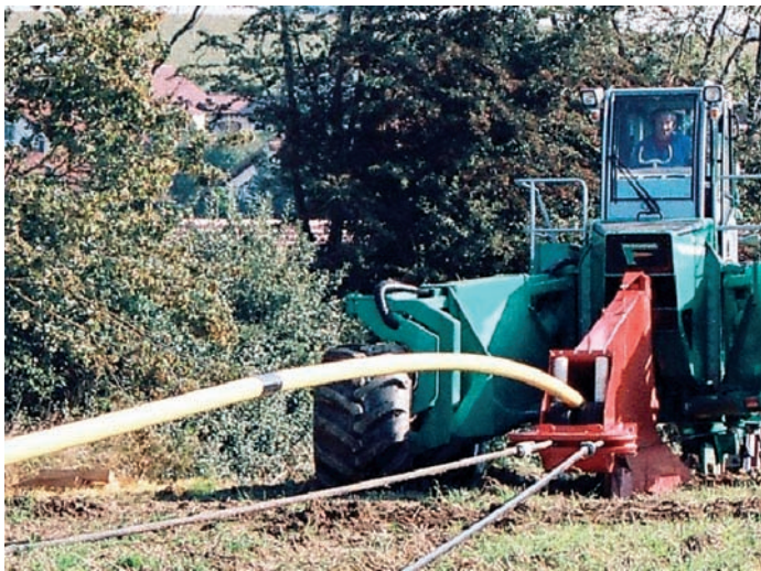
Bild 14: Strangführung mit Oberbogen
