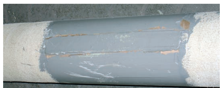
Bild 5: Kombination von FZM-Ummantelung und PUR-Gießharzsystem
