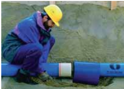
Bild 8: Einsatz von CANUSA-Schrumpfschlauch
