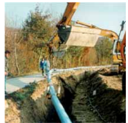
Bild 5: Strangverlegung verschweisster Rohre
