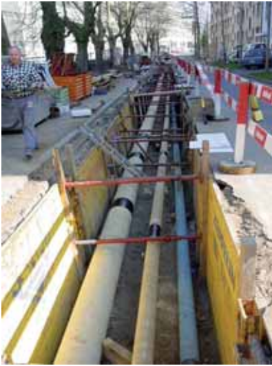
Einzelverlegung geschweisste Stahlrohre
