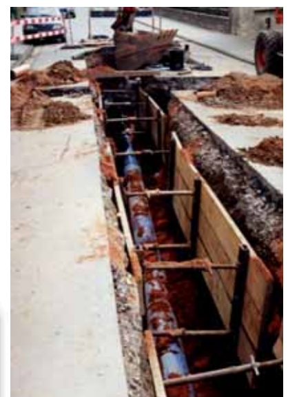
Bild 6: Einzelverlegung von Steckmuffenrohre
